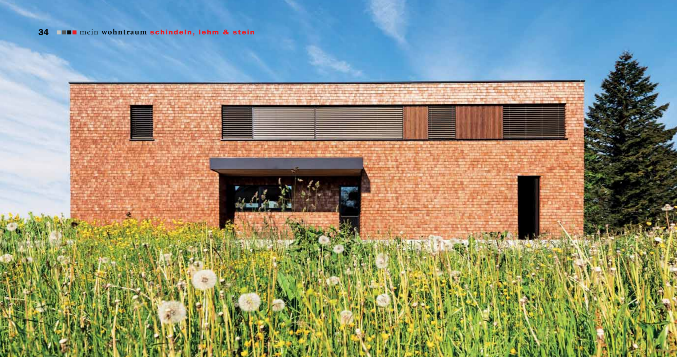
Die Spenglerarbeiten und Bauwerksabdichtung für das Vollholz-Haus führte das Team der Firma TECTUM aus.
